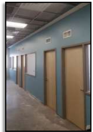
Maple Door Install
