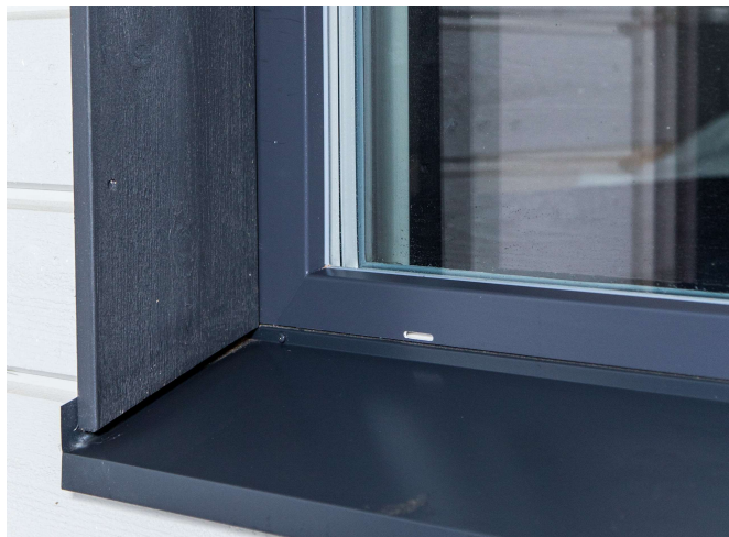
Kuva 6. Ikkunan vesipelti asennettuna.
