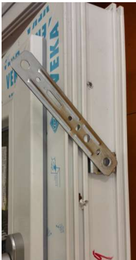
Kuva 1. Ikkunan kiinnike karmissa.
