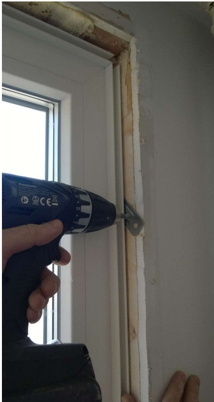
Kuva 2. Ikkunan kiinnittäminen runkoon.
